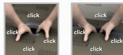
Les systèmes d'écoulement en un point ou en ligne sont dotés d'un système à clipser. Ce système assure le raccordement sûr et solide du siphon de sol au receveur de grille ou à l'écoulement en ligne. Un clic audible signale que le raccord est bien réalisé.
