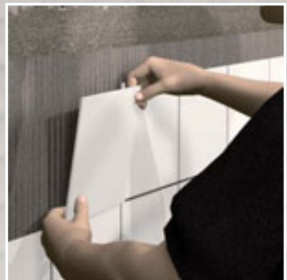
Plaatsen van tegels met het dunbedprocédé. Breng hiervoor tegellijm met een lijkam over het volledige oppervlak aan.
