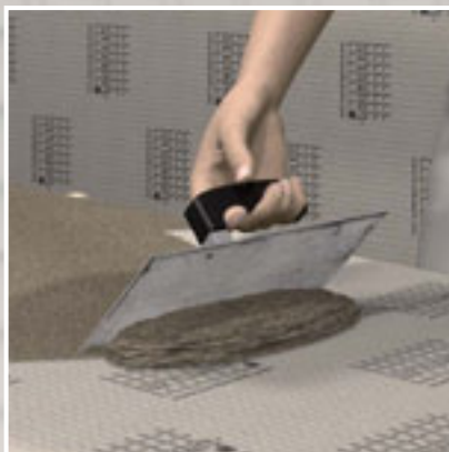
Het aanbrengen van aanzetlijm met een glad plamuurmes verdient aanbeveling bv. als contactlaag.
