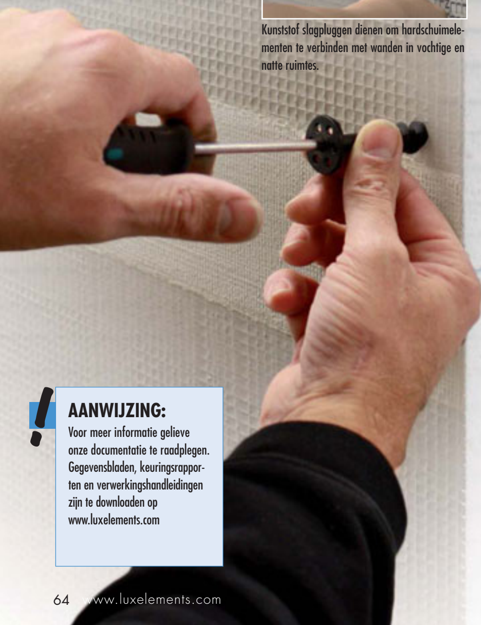
Met schroefpluggen van kunststof kunnen hardschuimelementen onderling worden verbonden.
