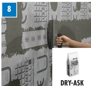
Le collage de la bande d'étanchéité découpée s'effectue avec DRY-ASK. Pour terminer, enduire de DRY-ASK.
