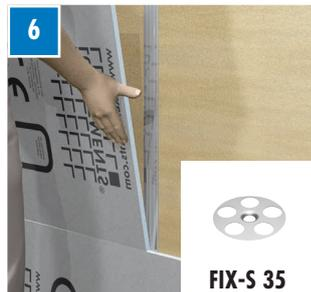
Ensuite, poser le prochain ELEMENT-VK sur le trait de colle. Après l'ajustement, visser à nouveau le panneau avec la rondelle FIX-S 35 + la vis appropriée.
