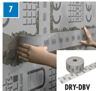
Étanchéifier joints et raccords entre les éléments et FIX-S 35 avec un petit morceau de bande d'étanchéité DRY-DBV et DRY-ASK. DRY-ASK s'applique au pinceau ou à la spatule.
