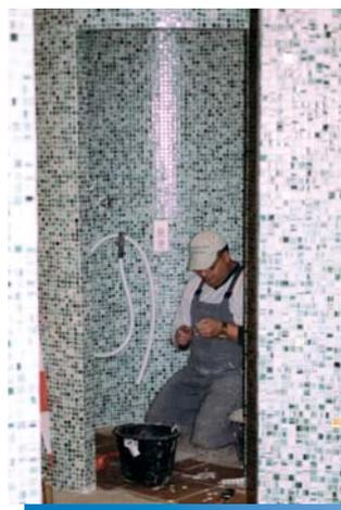
La douche circulaire prête à carrelage a été fabriquée avec les éléments porteurs en mousse dure de la gamme LUX ELEMENTS®-TUB de Lux Elements.
