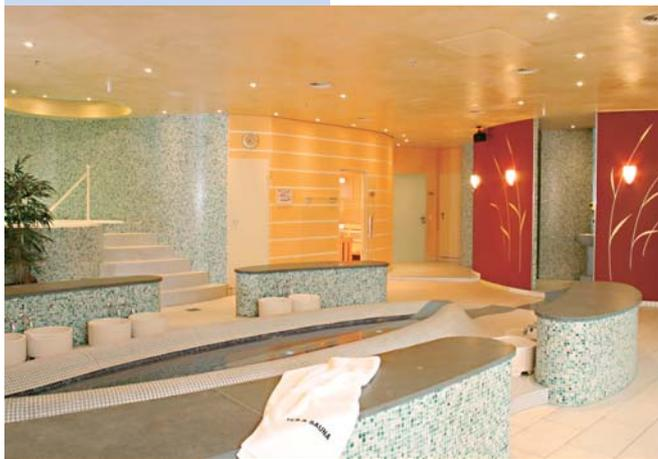
**Le centre de bien-être de Kassel complètement terminée. Toutes les formes souhaitées ont été exécutées à l'aide des éléments porteurs en mousse dure de lux Elements**
