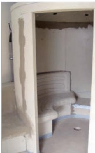
■ Vue détaillée banc: avec les éléments porteurs en mousse dure résistant à l'humidité, les formes arrondies peuvent se réaliser sans aucune difficulté.
