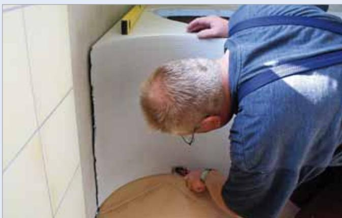
■ Le réglage de la hauteur des éléments d'habillage s'effectue à l'aide de vérins intégrés.
