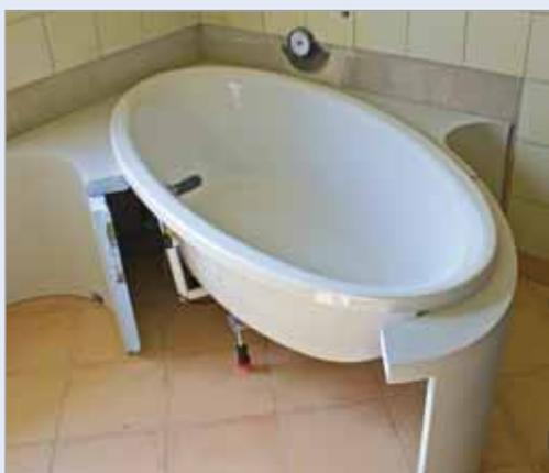
■ La baignoire est mise en place lorsque toutes les parties fixes sont ancrées. Les tuyaux sont ensuite raccordés et les éléments libres restant sont collés aux pièces fixées dans le mur. On utilise pour cela la colle de montage LUX ELEMENTS®-COL-PU.
