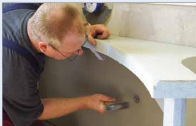
■ Ensuite, l'habillage est collé sur sa face arrière et fixé contre le mur à l'aide de chevilles à frapper LUX ELEMENTS®-FIX-FID 130.
