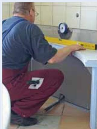
■ Le montage par étapes : L'installateur aligne les pièces préfabriquées à l'aide d'un niveau à bulle. Il contrôle l'assemblage et les dimensions des éléments.
