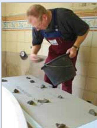
■ A l'endroit où se trouvent les trous, une colle d'application LUX ELEMENTS®-COL-AK est appliquée au dos des éléments d'habillages.
