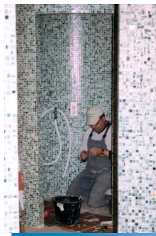
De ronde douche klaar voor betegeling werd uit dragende hardschuimelementen van de productlijn LUX ELEMENTS®-TUB vervaardigd.
