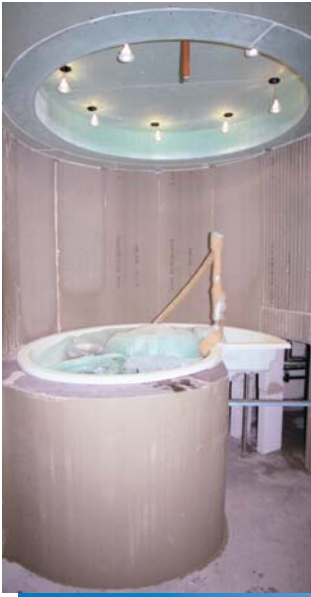
Dompelbad in de constructie met ronde wand voor het aanbrengen van de treden en voor de betegeling. Het dompelbad na voltooiing.
