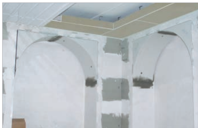
■ ... de rondbogen boven de dichtgemetselde vensters en ...
